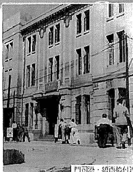
門司港・鎮西橋付近
